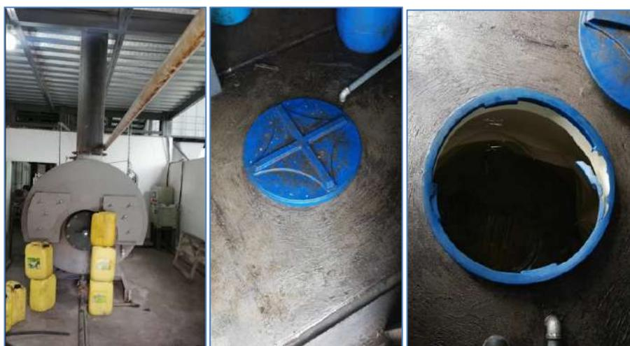
El área donde se encuentra el caldero es compartida con un tanque de recirculación de aguas de procesos y un tanque de combustible que no cumplen las características requeridas para almacenamiento de combustible ya que es un tanque plástico tipo cisterna de 1000 litros.
